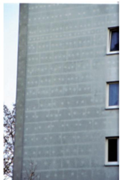
Südwest-Fassade mit Wärmedämmverbundsystem (WDVS)
